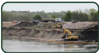
Reparaciones de terraplén en el río Big Sioux en IA Hwy 12.
